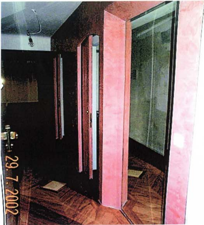
Vorraum mit Einbaukasten Beschichtung mit Spatolato Veneziano (Stuccolustro - Stucco Antico)
